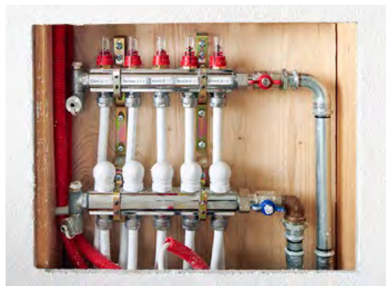
Verteiler des Fussbodenheizungs-Systems.
